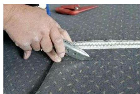
Ist dies nicht möglich, weil das Muster nicht parallel zur Nahtgasse verläuft, ist mit Rollstahllineal und scharfer Hakenklinge parallel zum Muster bzw. zur Druckkante zu schneiden.
