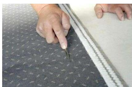
Der Nahtschnitt entlang des markierten Gassenverlaufs kann sowohl mittels Florgassenschneider, als auch mittels scharfer Hakenklinge erfolgen.
