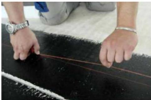
On commencera la pose en partant du point d'intersection de ces deux lignes après avoir enduit la surface totale correspondant à la dimension de la dalle à poser avec le produit de fixation pour dalles WULFF HV 9 (les instructions du fabricant du produit de fixation doivent toujours être respectées.)
